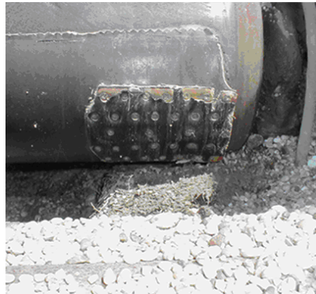
6. Super-Screw beszakadás javításakor:
